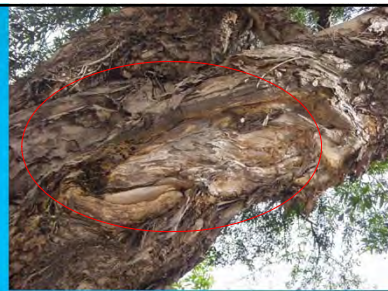
樹乾外部可見明顯白蟻蟻路
